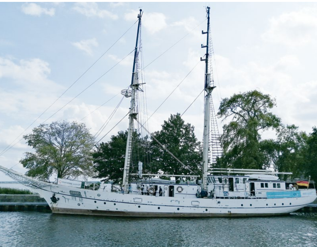
Einst der Stolz der DDR, heute ein Sanierungsfall: der Zweimaster GREIF ex WILHELM PIECK
