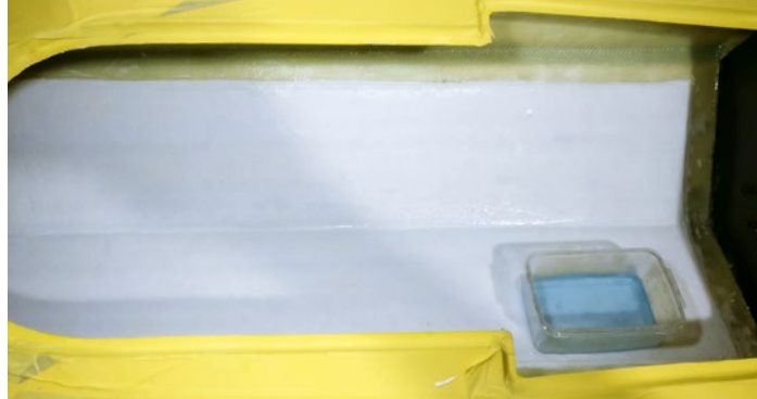
Die Stringer sind verfüllt. Die Glaslage dient als Basis für den Schaumstoff. Die beiden Sandwichzuschnitte sind 3 mm dick und versteifen fast den kompletten Rumpfboden
