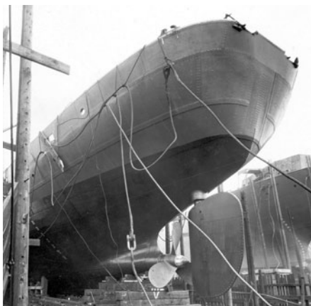
Diese Aufnahme zeigt schön die außergewöhnliche Form des Hecks und den Drei-Flunken-Propeller
