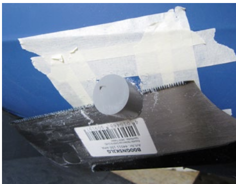
Eine Säge ist ideal fürs Abtrennen des überstehenden Rohrs und Kreppband schützt
