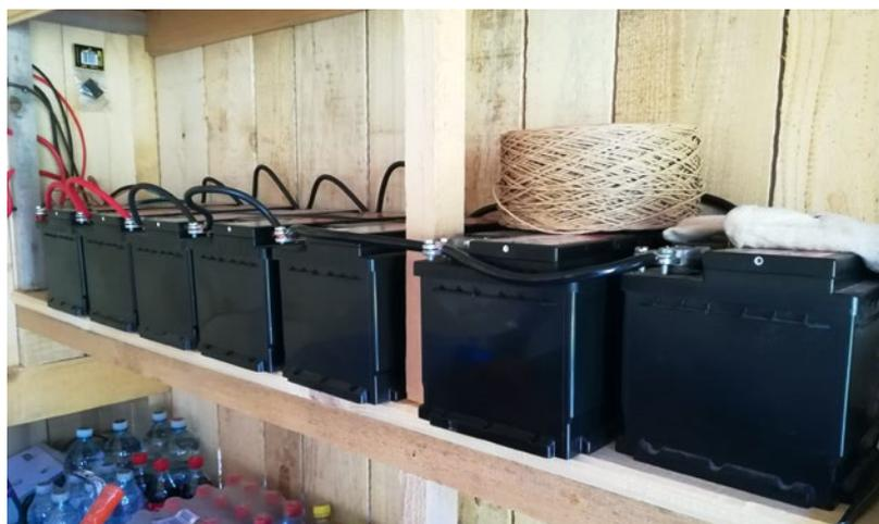
**Über einen Solarregler wird diese leistungsfähige Bleiakku-Bank mit 560 Ah geladen. Einzig die maximale Belastbarkeit ist von den Nutzern zu beachten**
