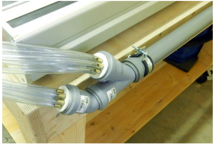
Die HT-Rohre sind über Schellen seitlich am Tisch sicher befestigt
