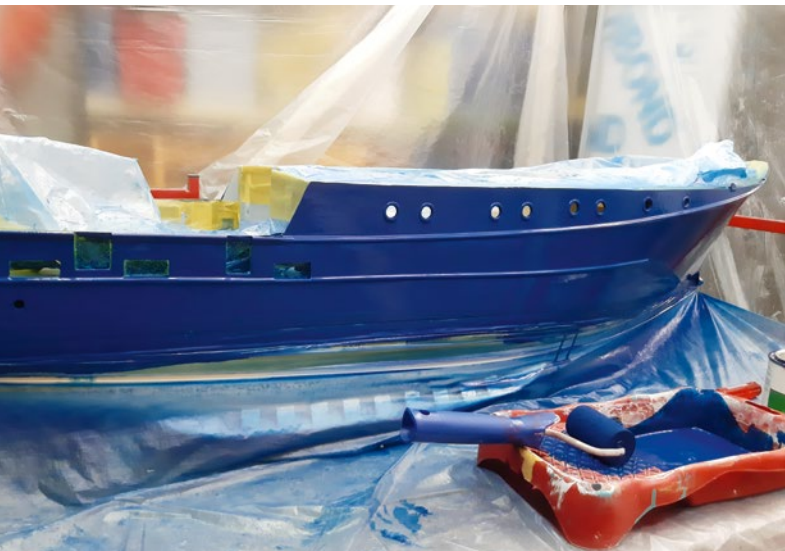
Das Überwasserschiff wird mit der Rolle tiefblau gestrichen
