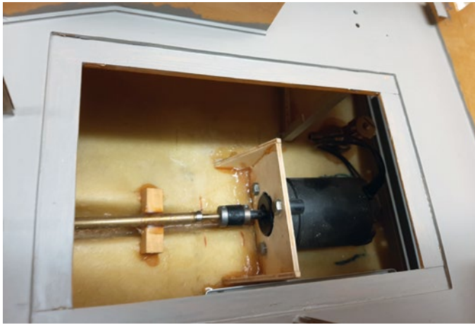
Der Zugang zum Antrieb auf dem Sortierdeck war eigentlich nicht vorgesehen
