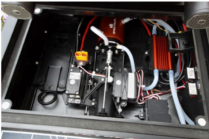
Der Maschinenraum macht einen sauberen und aufgeräumten Eindruck
