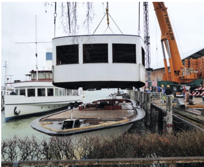
Während die neue MS UTTING auf dem Ammersee zusammengesetzt wurde, ging es für die alte andersrum. Auch sie ließ sich nur in Segmenten aufgetrennt zum neuen Bestimmungsort verbringen
