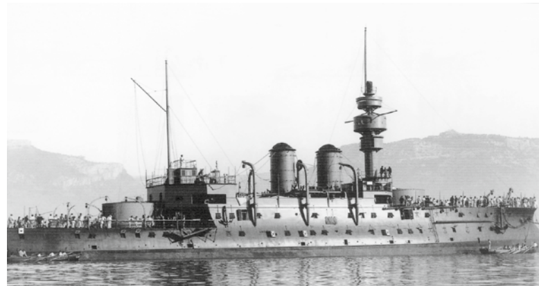
Abbildung 5: Der dunkle Streifen über der Konstruktionswasserlinie bei BOUVINES zeigt die Höhe des Gürtelpanzers an. Die kleine Hütte vor dem hinteren Mast ist eine Admiralskammer. Die Beiboot-Barkunen neben dem Gefechtsmast sind nach vorn umgelegt; die großen Bootsdavits nach innen geschwenkt
