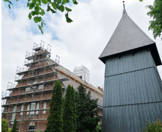
Die Kirche St. Petri in Landkirchen auf Fehmarn, seinerzeit zur Renovierung eingerüstet
