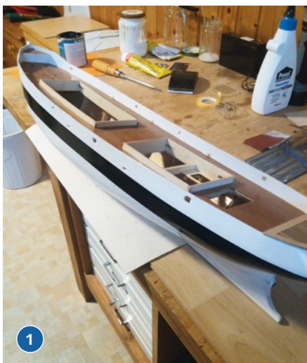
Der fertige Rumpf wird geschliffen und mit Glasgewebe überzogen
