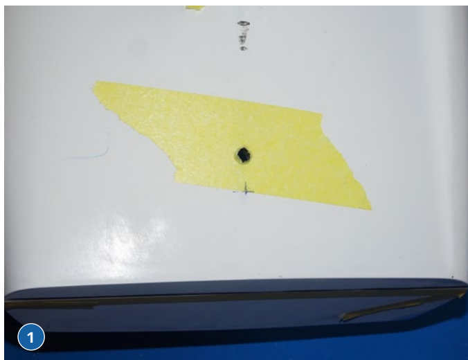
1) Die Position des Ruderkokers wird auf dem mit Klebeband geschützten Rumpfboden mittig hinter dem Stevenrohr angezeichnet und auch von außen gebohrt. 2) Um dem Ruderkoker einen festen Halt im Rumpfboden zu geben, habe ich einen Hartholzklötz auf den Boden geklebt
