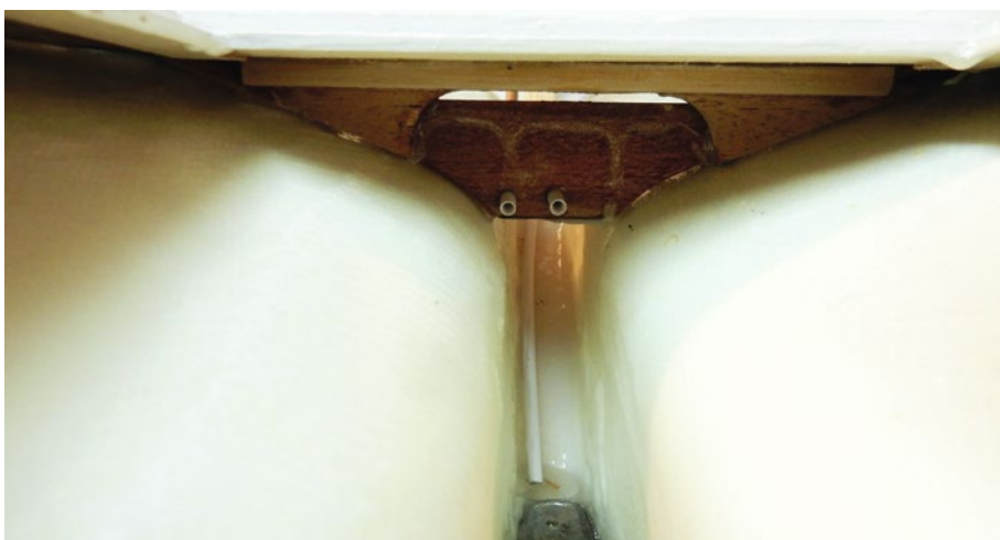
Die Röhrchen für die Spanten werden eingezogen und enden tief unten im Rumpf
