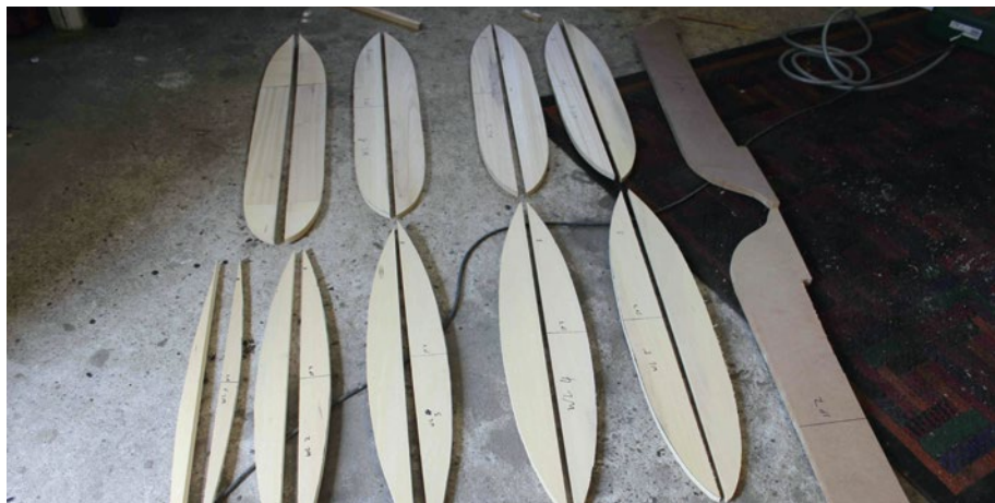
Zum Erstellen einer festen Tiefziehform wurde der Rumpf in Schichtbauweise aus Massivholz gebaut
