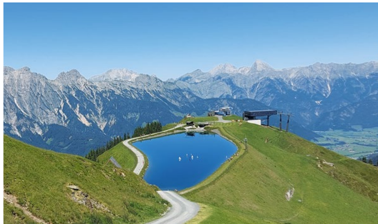
Die Location ist einzigartig in vielerlei Hinsicht: die Lage des Sees auf dem Bergkamm sorgt für eine atemberaubende Aussicht, aber nicht immer für eine eindeutige Windrichtung
