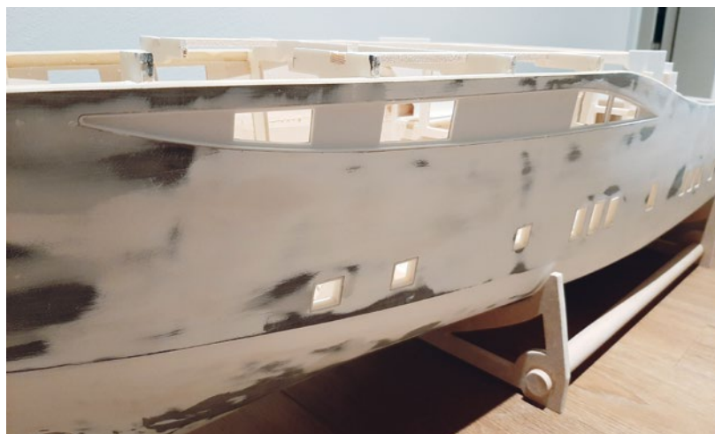
Immer wieder muss geschliffen werden, bis die Oberfläche glatt ist
