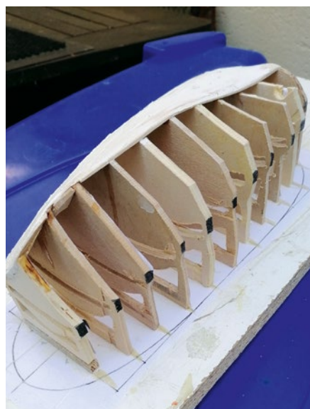
Die Positiv-Form für die JOHANN FIDI entstand in klassischer Bauweise
