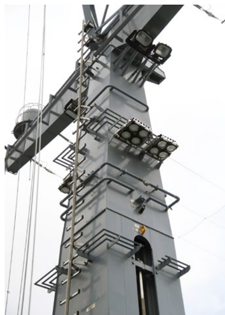
Der RAS-Mast mit seinen vielen Anbauten
