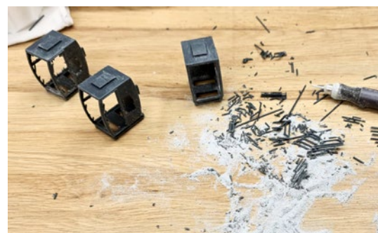
Danach mussten die Stützen entfernt und die Kabinen verputzt werden
