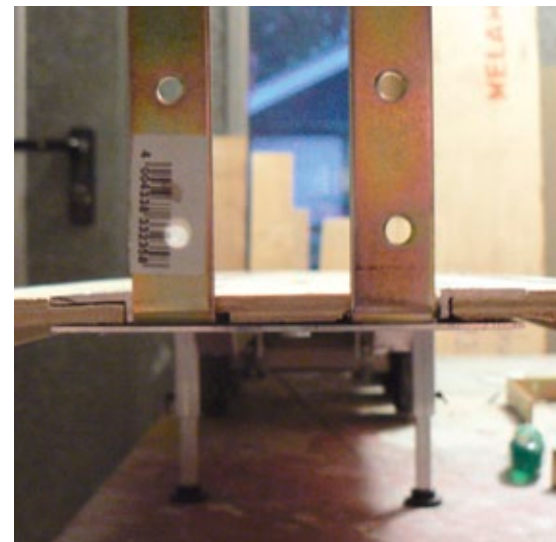
Durch die Montage der Winkelverbinder bekommt die Stirnwand ihre Stabilität
