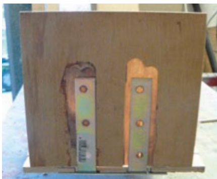
Eine Sperrholzplatte dient als Basis für die Stirnwand. An der Stelle der Winkelverbinder wurde diese entsprechend dünner geschliffen
