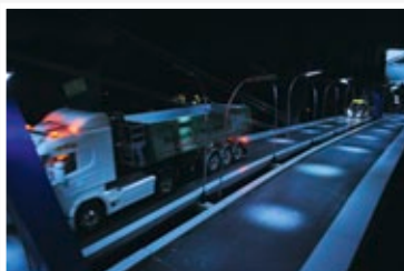
Als es abends langsam dunkel wurde, konnten die Besucher die Beleuchtung der Brücke in ganzer Pracht genießen
