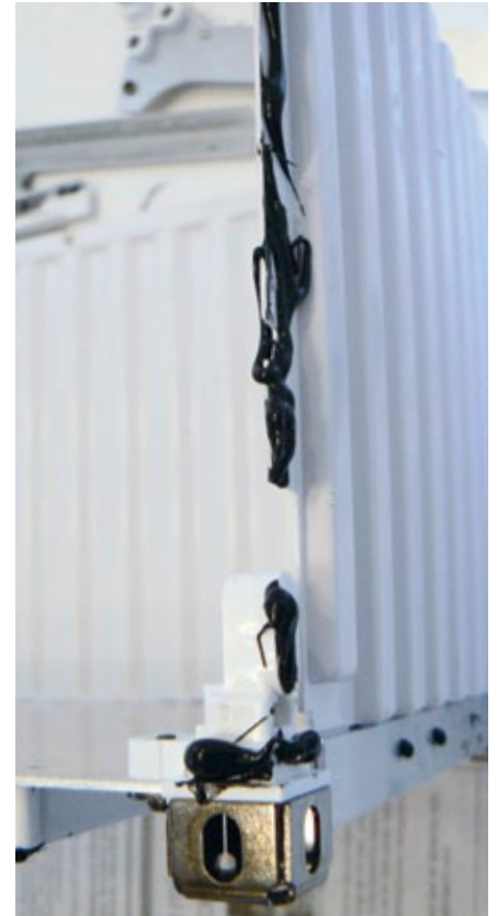
Sikaflex hält den Container schraubenfrei zusammen
