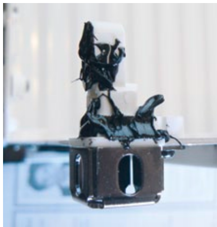
Vorbereitung zum Verkleben mit Sikaflex an den Container-Ecken
