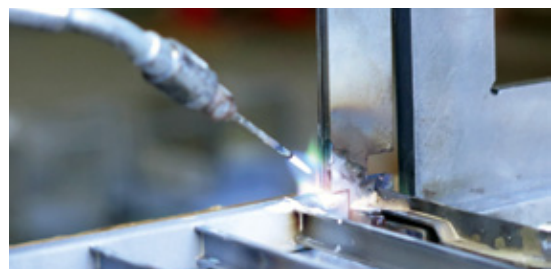
Hartlöten eines Finescale-Containers: Die Verfärbungen der Bauteile entstehen durch den Wärmeeinfluss der Flamme. Nach dem Sandstrahlen ist davon nichts mehr zu sehen
