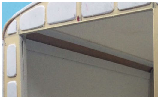
Am Übergang von der Seitenwand zum Dach sind innen die Hinterfütterungen an den Stoßnähten zu erkennen
