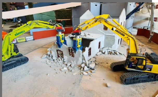
Die Abrissarbeiten sorgten für besondere Aufmerksamkeit unter den Besuchern
