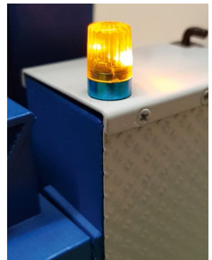
Eine Rundumleuchte wird auf dem seitlichen Kasten installiert
