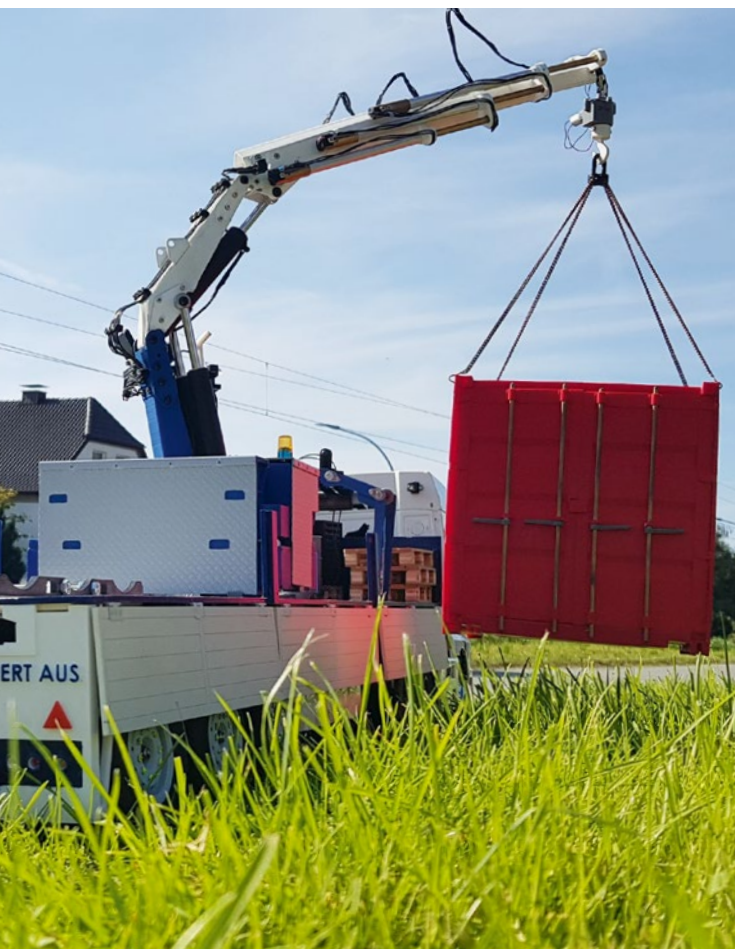
Im zweiten Teil des Bauberichts geht es um die Konstruktion des Krans selbst
