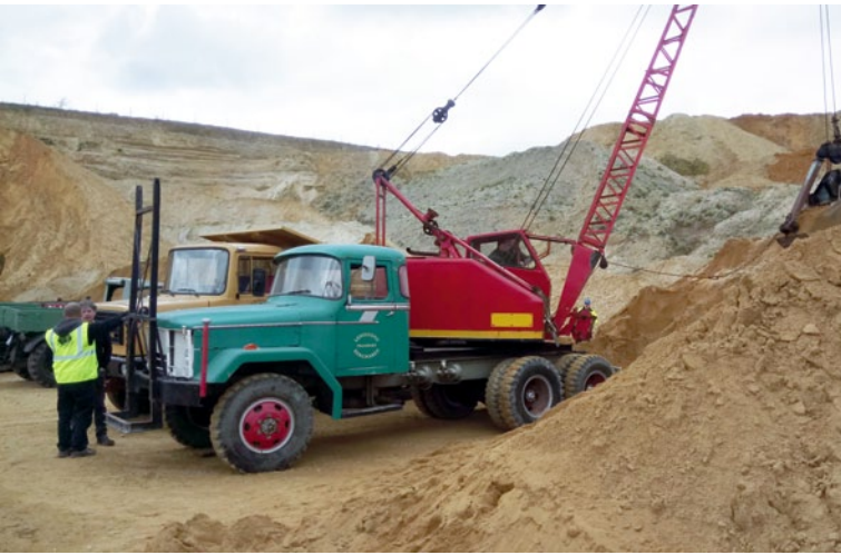
Da das Treffen in einer Kiesgrube stattfand, gab es natürlich auch reichlich Gelegenheit zum Baggern und Graben
