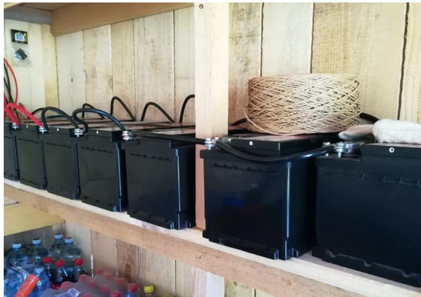
Über einen Solarregler wird die leistungsfähige Bleiakku-Bank geladen. Einzig die maximale Belastbarkeit ist von den Nutzern zu beachten
