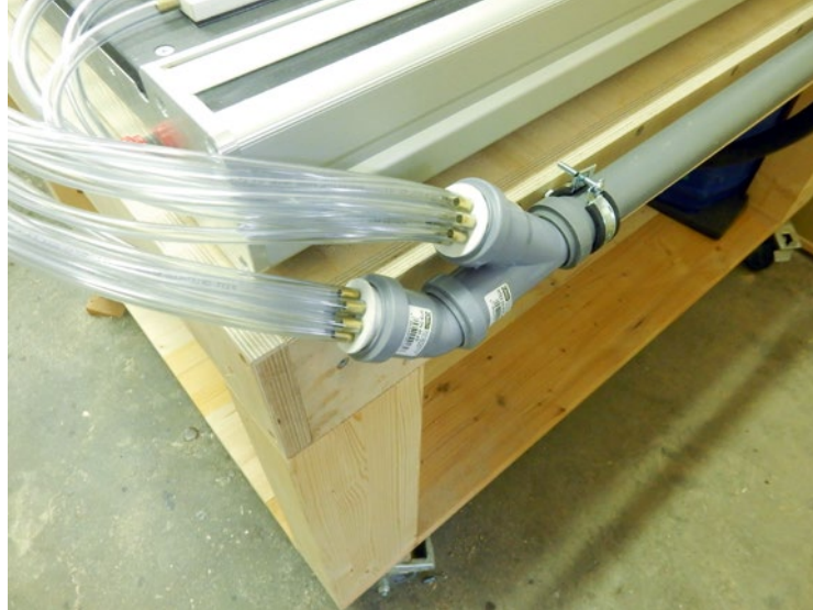
Die HT-Rohren sind über Schellen seitlich am Tisch sicher befestigt
