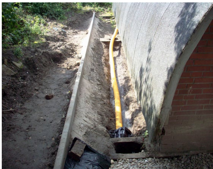
Zur Versorgung mit Strom und Wasser sind entsprechende Leitungen zu verlegen, ehe es mit dem eigentlichen Parcours-Bau so richtig losgehen kann
