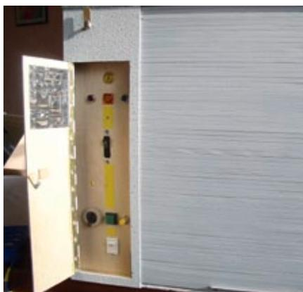
Die Schalt- und Kontrollelemente hinter der Tür für Beleuchtung sowie die Kontrolle der Nebelmaschine und der Ablaufsteuerung
