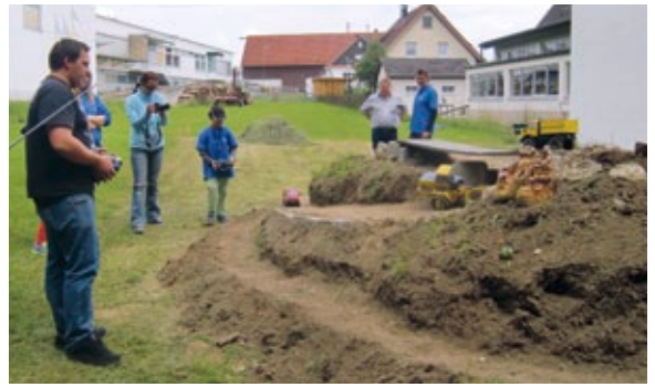
Die Außenanlage ist aktuell im Entstehen
