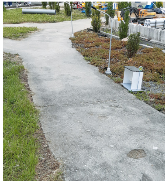
Die Rasenflächen wurde bündig mit der Straßenoberfläche gestaltet, damit die Modelle beim „Verlassen“ der Straße nicht in eine Kante herabfallen und beschädigt werden
