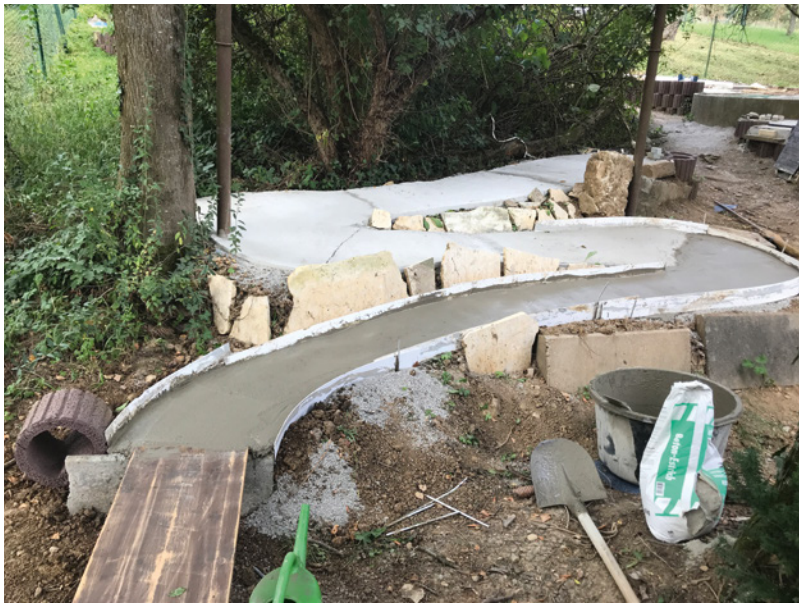
Beim Betonieren der Straße wurden spätere Parcours-Elemente wie Brückenpfeiler bereits mitgedacht
