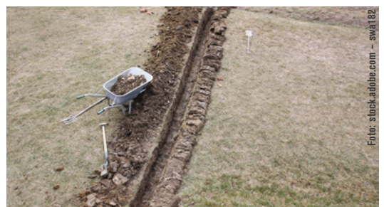
Damit auch Jahre nach dem Parcoursbau klar ist, wo Strom- und Wasserleitungen angelegt wurden, sollte deren Verlauf gut dokumentiert werden
