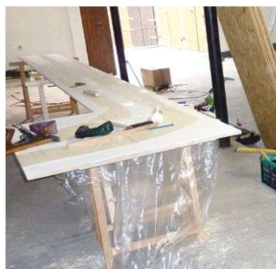
Die Fahrbahnfläche der am Ende über 7 Meter langen Brücke entsteht aus Fichtenholzplatten, die durch Holzleisten verstärkt wurden
