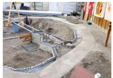
Der Rohbau der gut 10 Meter langen Brücke. Die Auffahrt wurde aus Zement gefertigt. Gut zu erkennen auch die Stahlrohre, auf denen die Fahrbahn (Siebdruckplatten) ruhen wird
