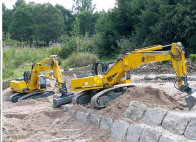
Zwei Liebherr-Bagger beim Straßenbau in ihrem Element
