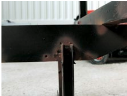
Auch die Klappstütze hat schon Rost und Dreck angesetzt
