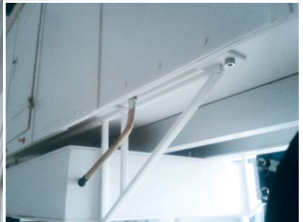
Neben Abflussleitungen wurden auch Wasserhähne montiert
