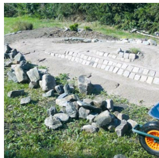
Das Material für eine weitere Stützmauer
