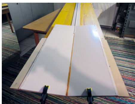
Auf dem Tisch liegt eine waagrecht ausgerichtete Mehrschichtplatte, auf der mittels Holzkonstruktion die spätere V-Form der Rumpfs montiert ist. Die ersten beiden 800 Millimeter langen und 2 Millimeter starken ABS-Platten liegen schon in der Form
